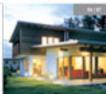
Stavbna stavbna stavba | The House of the Woods
