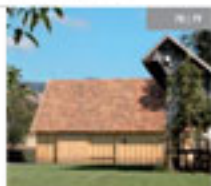
Stavbna stavbna stavba | The House of the Woods
